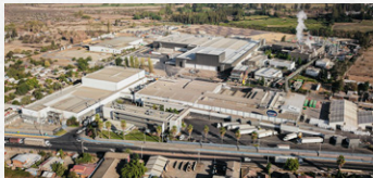
로 미란다 공장 (Lo Miranda Plant)
