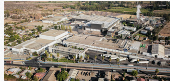
로 미란다 공장 (Lo Miranda Plant)
