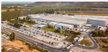
산 비센테 공장 (San Vicente Plant)
