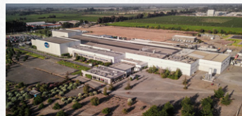
로사리오 공장 (Rosario Plant)
